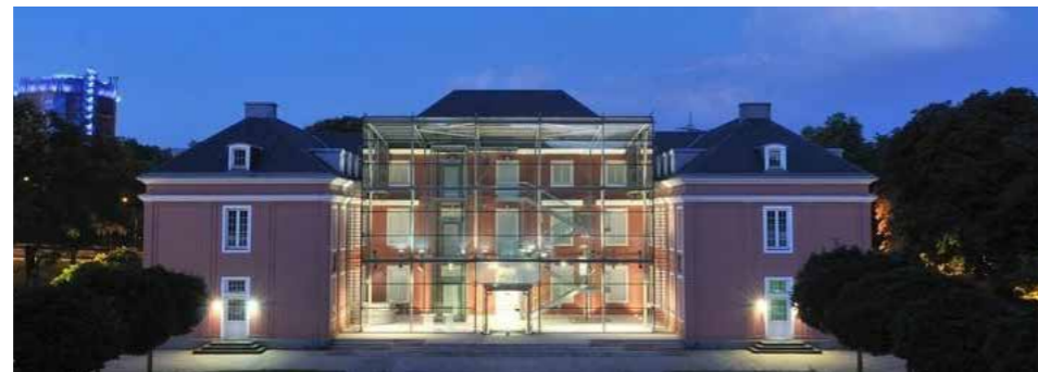
Museum Schloss Oberhausen/Germany 1995-2000, completed Client Schloss GmbH, Oberhausen GFA 3.700 m 2
